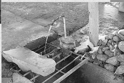
Утечка воды (как одна из причин слабого напора)
