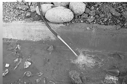
Утечка воды (как одна из причин слабого напора)
